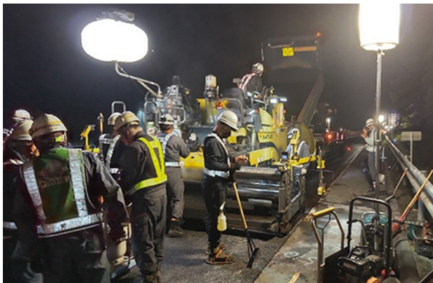
舗装補修工事
