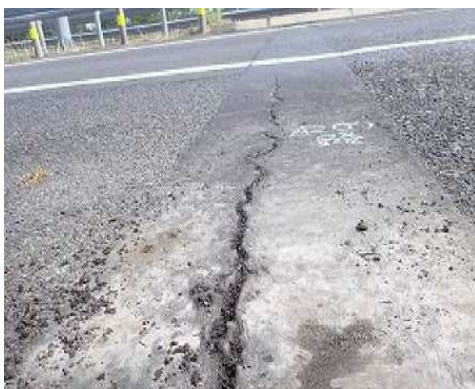
伸縮装置状況
