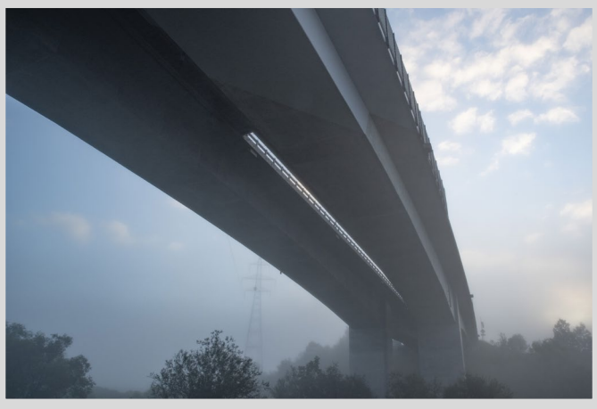
道央道/旭川鷹栖IC～深川IC/2022年8月撮影
