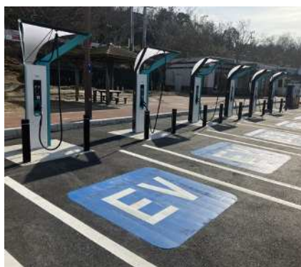
写真-1 マルチコネクタタイプ(6口)EV 急速充電器 (左: E4 東北道 蓮田 SA(上り線)、右: E1 名神 草津 PA(下り線))
