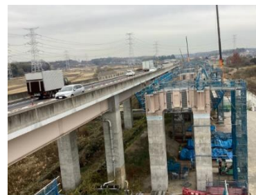
4車線化に伴う工事 作業状況
