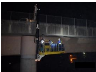
道路構造物点検 作業状況
