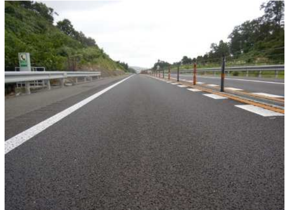
舗装補修後イメージ
