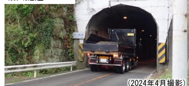
(2024年4月撮影) 狭隘トンネルを通過する大型車
