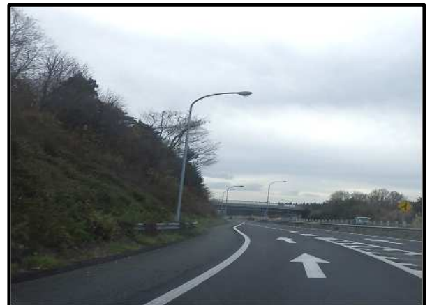
舗装部損傷完了後イメージ
