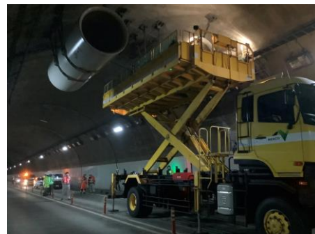
トンネル点検
