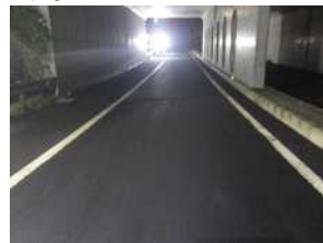
舗装補修後イメージ
