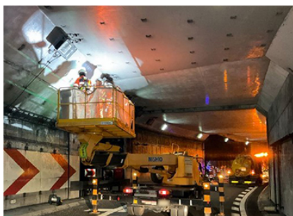
カルバートボックス点検状況 イメージ
