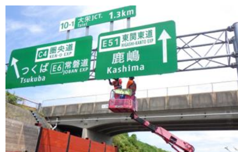
標識点検状況 イメージ
