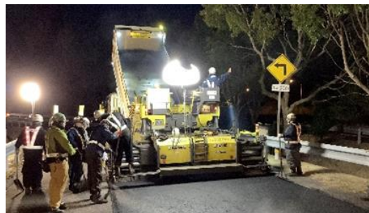
舗装補修工事 作業状況
