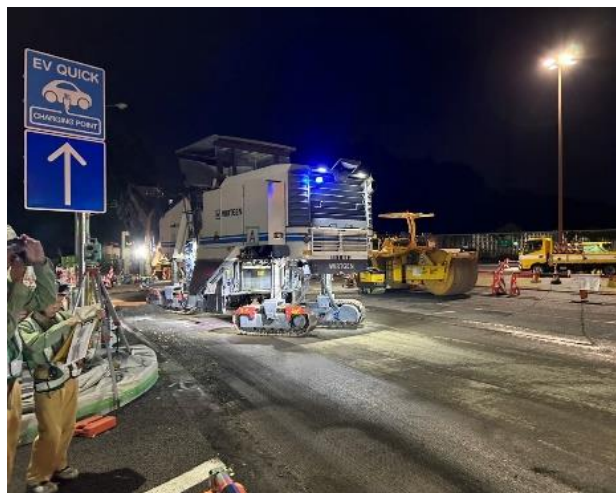
舗装工事 作業状況
