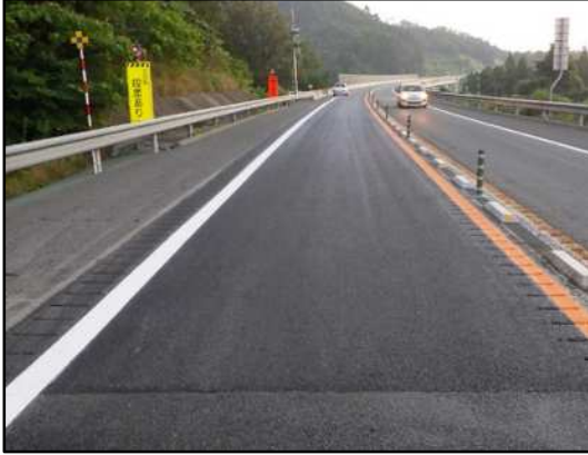
舗装補修工事写真
