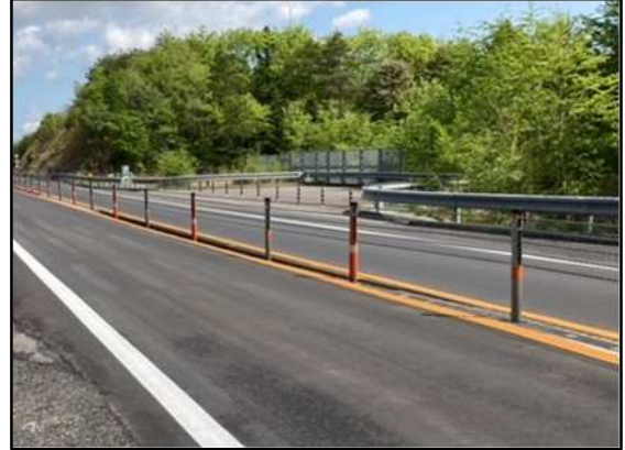
車線区分柵設置工事写真
