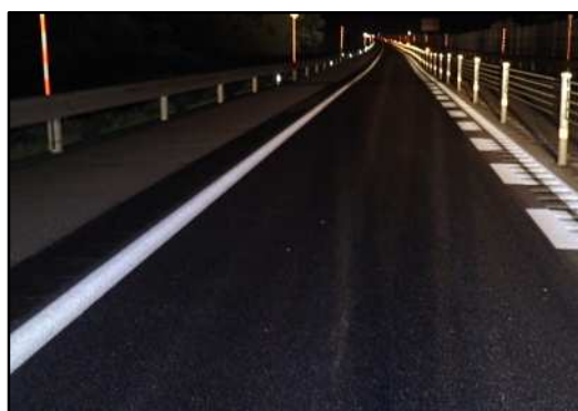
舗装補修後イメージ
