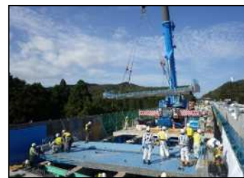
【新しい床版設置状況】
