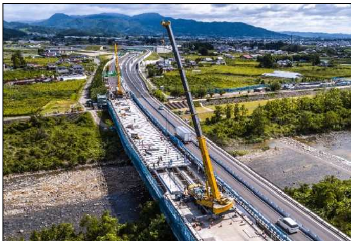
【対面通行規制状況】
