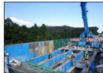
【古い床版撤去状況】
