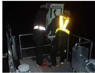
非常電話移設状況
