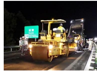
舗装補修工事状況
