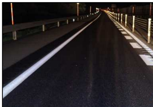
舗装補修後イメージ
