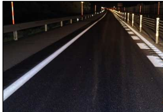
舗装補修後イメージ
