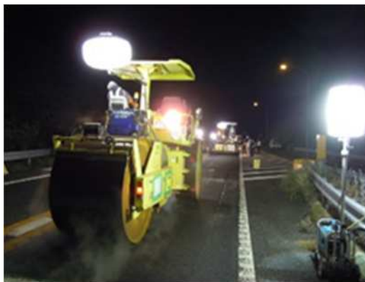
舗装補修工事
