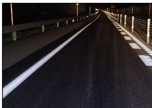
舗装補修後イメージ
