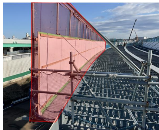
撤去する足場
