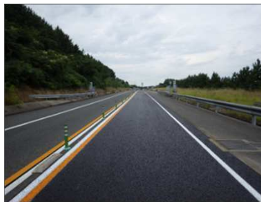
舗装補修後イメージ
