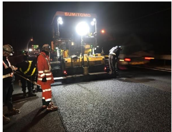
舗装補修工事 作業状況
