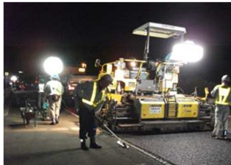
舗装補修工事 作業状況
