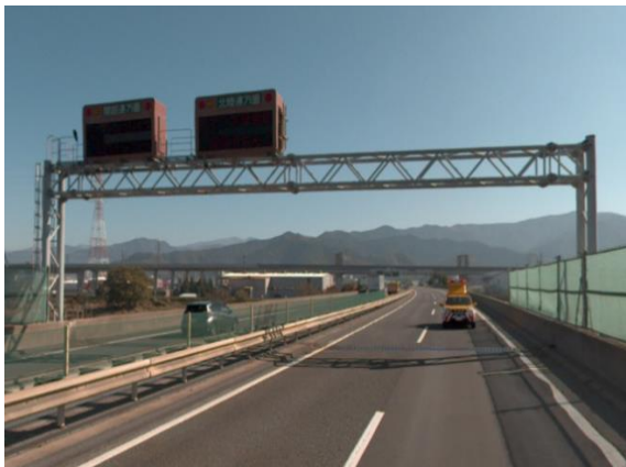
作業箇所 現況
