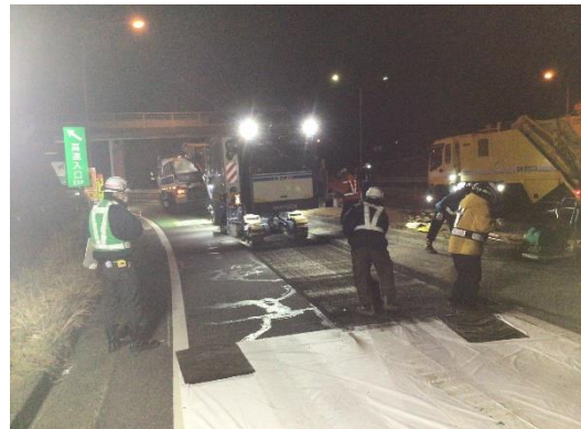
舗装補修工事作業状況
