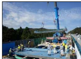
【新しい床版設置状況】
