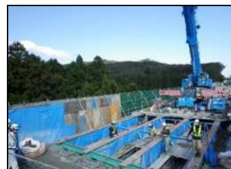
【古い床版撤去状況】
