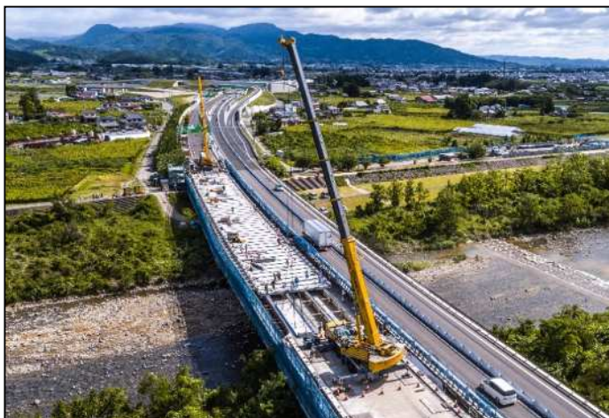
【対面通行規制状況】
