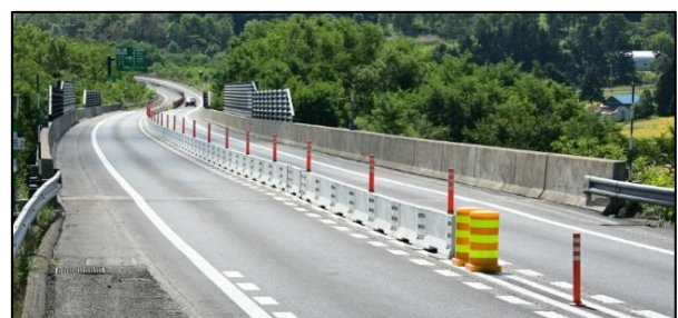
道央道 比布JCT～和寒IC間(蘭留宗谷橋) センターブロック設置状況
