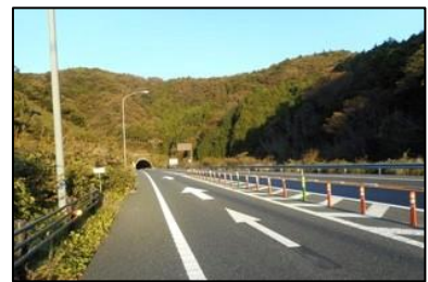
大型矢印路面標示・ラバーポール延伸
