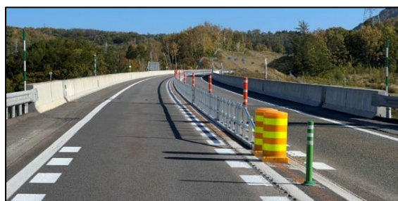
後志道 小樽JCT～小樽塩谷IC間(伍助沢橋) センターパイプ設置状況
