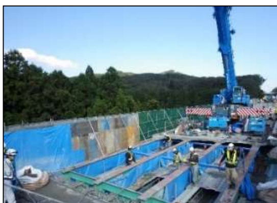
【古い床版撤去状況】
