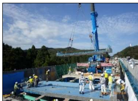
【新しい床版設置状況】
