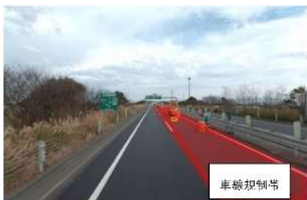
片側2車線道路の場合 ⇒車線規制での工事を実施
