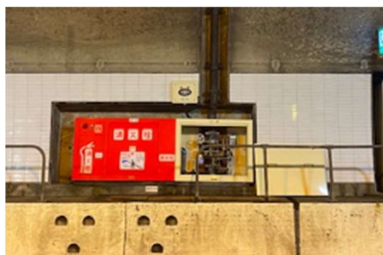
非常用設備更新
