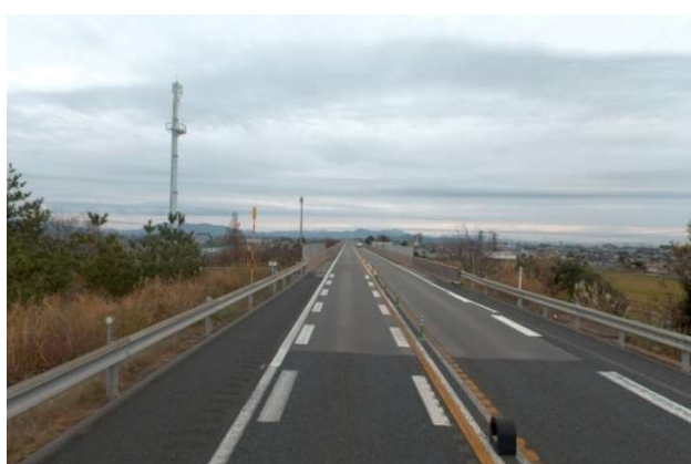
片側1車線道路の場合 ⇒通行止めでの工事を実施
