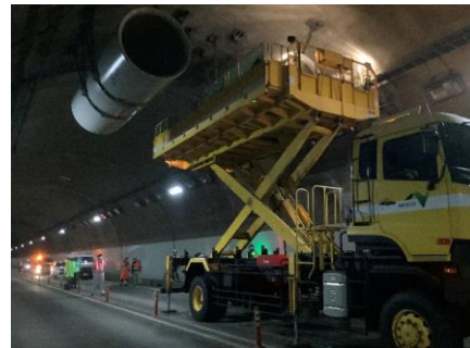
トンネル点検例
