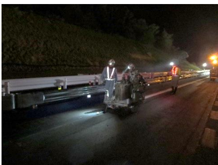
4車線化工事(路面標示)例
