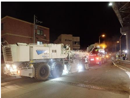
路面補修工事例
