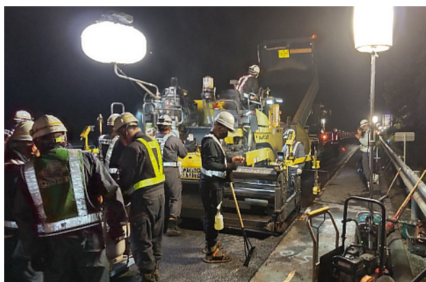
舗装補修工事
