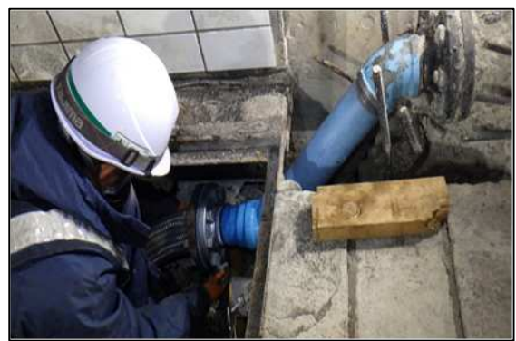
トンネル内配管補修作業
