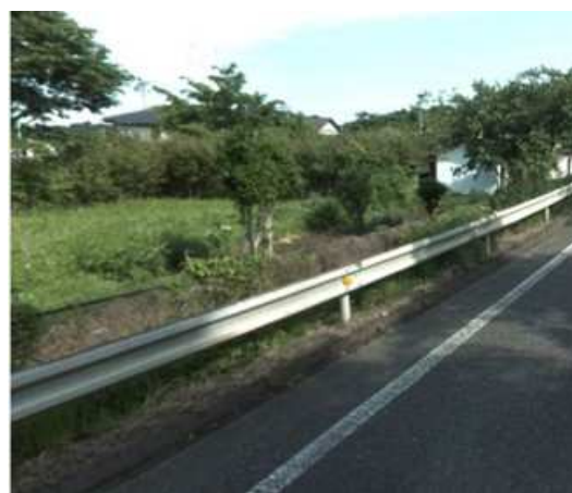
防護柵補修完了後イメージ
