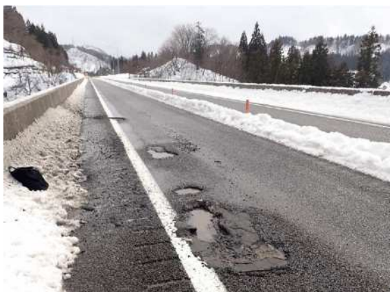
損傷した路面状況①
