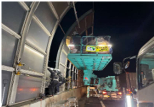
遮音壁取替工事 作業状況
