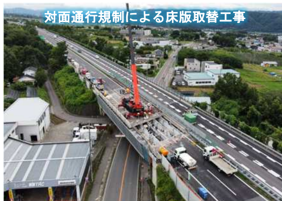
上信越自動車道 金井橋床版取替工事
