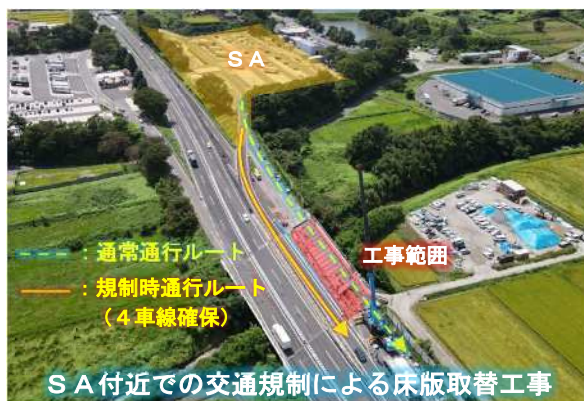
東北自動車道 安達太良川橋床版取替工事
