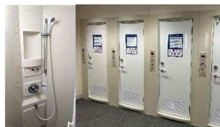
東北自動車道 安積PA(上下線) シャワー施設
