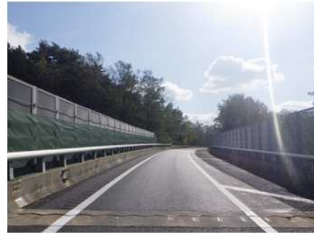
舗装補修後(イメージ)
