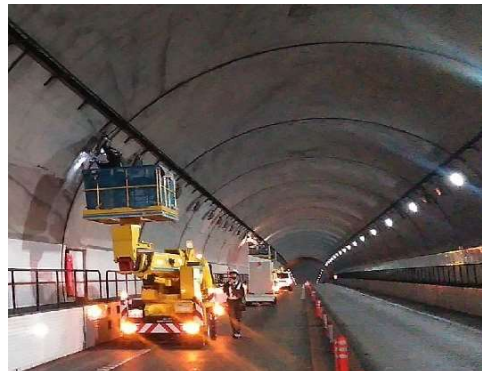
道路構造物点検作業状況
