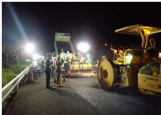
舗装補修工事
