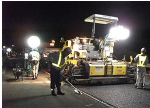
舗装補修工事 作業状況
