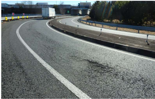
路面損傷状況
