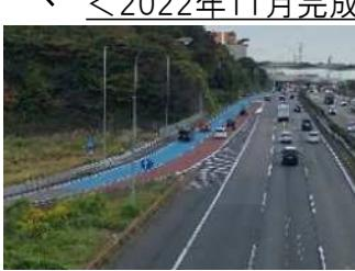
合流部の渋滞緩和のため横浜町田ICの加速車線を延伸しました。さらに、2車線ランプを分離型としスムーズな合流を可能とするためカラー舗装を施工しました。
