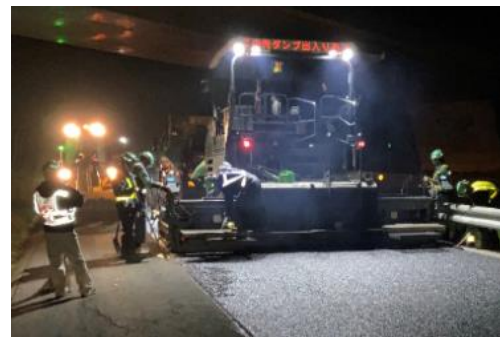
路面補修工事例
