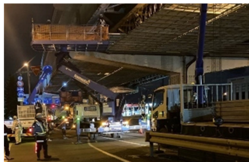
足場設置工事例
