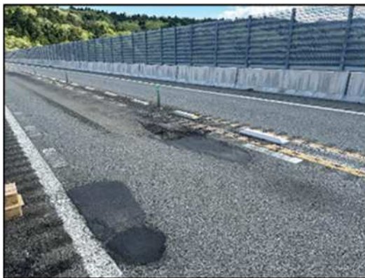
道路保全工事 施工前写真
