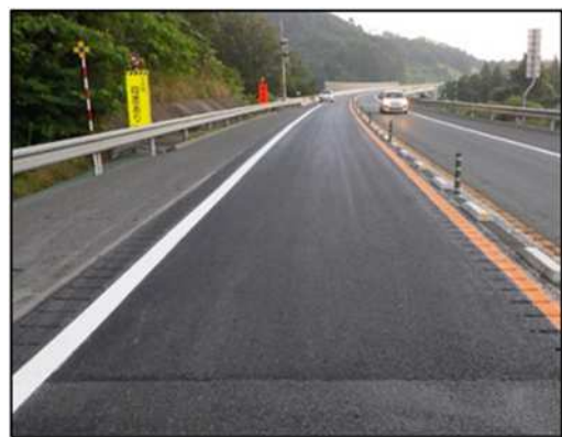
道路保全工事 施工後写真(イメージ)
