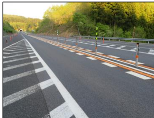
舗装補修後イメージ
