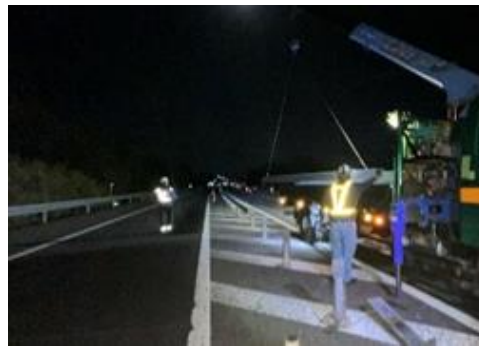
ボックスビーム撤去工 作業状況
