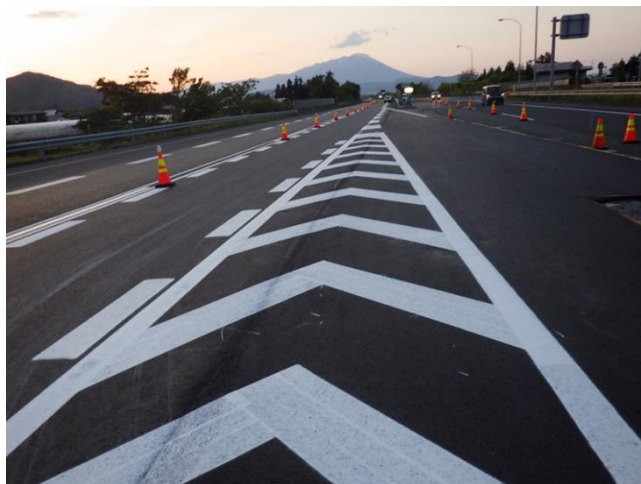
路面標示工事イメージ
