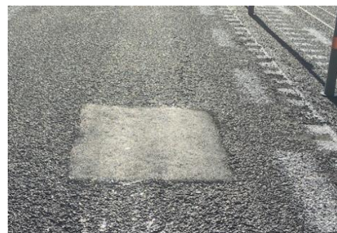
舗装補修後イメージ
