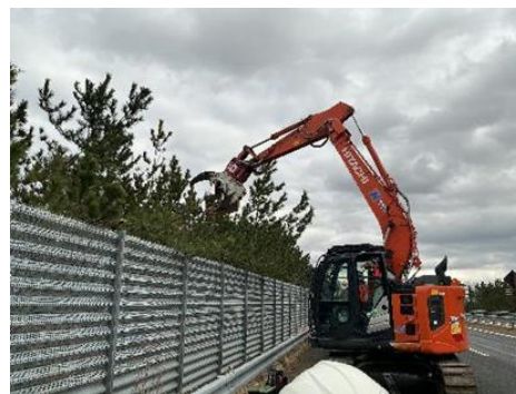
高伐作業写真
